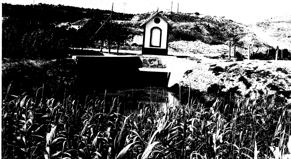
Figura 9. Toma de Riegos de Levante Margen Derecha, aguas arriba del azud de San Antonio en Guardamar del Segura, cuyos caudales discurren por un túnel de algo más de 1.000 metros de longitud hasta la estación de bombeo que se halla en sus inmediaciones. Se trata de una concesión administrativa de aguas sobrantes del citado río, otorgada en 1918 a un gran terrateniente para derivar un caudal de 500 litros/seg. La licencia fue traspasada en 1921 a la Compañía Riegos de Levantes S. A. a cambio de que dicho hacendado recibiera el 11% del agua elevada para regar fincas de su propiedad, entre ellas El Bancalón y Las Moreras en Los Montesinos. La entidad mercantil realizó todas las obras de captación, impulsión y distribución de caudales, con un objetivo meramente especulativo: la venta directa de agua a los agricultores que tuvieran sus tierras por debajo del nivel de la infraestructura del canal principal de conducción. Se logró de esta forma poner en riego unas 3.500 hectáreas de secano, circunstancia que redundó en el desarrollo económico de Los Montesinos.
