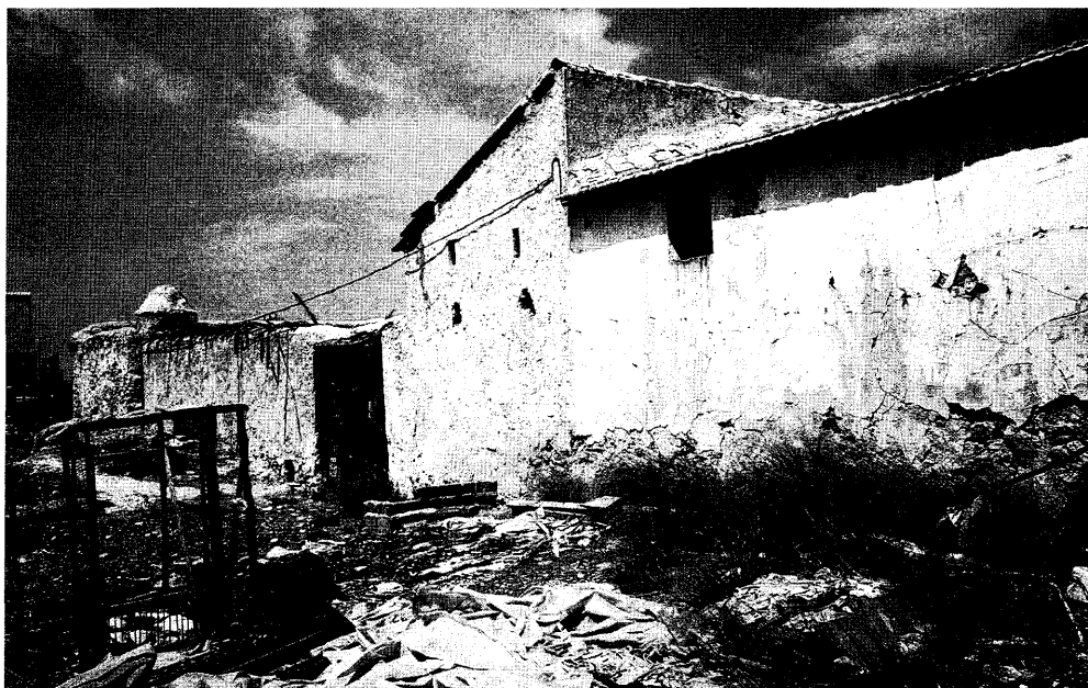
Figura 12. Imagen actual de la heredad Lo Vigo Viejo, cuyo calificativo manifiesta su pertenencia a una hacienda de mayor tamaño que, para hacer viable su explotación, se subdividió en dos porciones. Las edificaciones que la conforman se juxtaponen según surgen las necesidades en el laboreo de la tierra. Alrededor del patio conserva almazara, borno, aljibe, palomar y otras dependencias. En ella culminaba, como en las restantes propiedades del secano, todo el proceso de cultivo, recolección y elaboración propias de una economía de subsistencia.
