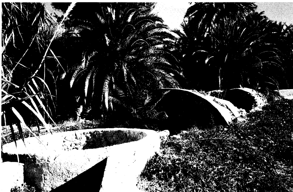
Figura 14. Aljibe con bóveda de cañón y cubeta de decantación en La Marquesa. Su existencia está documentada a mediados del siglo XVIII, coincidiendo con el establecimiento de colonos realizados por los jesuitas oriolanos, propietarios de la heredad, para garantizar el abastecimiento de agua a este primer núcleo poblacional, que alcanzó la mayor entidad entre las grandes haciendas del secano. El almacenamiento de aguas llevó consigo costosas labores de preparación del terreno para aprovechar la escorrentía natural de las aguas de lluvia y canalizarlas a través de las ramblas hacia estos depósitos.
