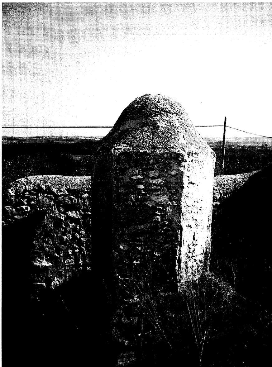
Figura 26. El aljibe de Lo de Vigo Viejo es un exponente de la arquitectura del agua tan típica en el secano del Bajo Segura. Se trata de una construcción de mortero de cal y piedra caliche, rebocada de yeso. El edificio comprende dos partes, una exterior rematada en capilla de forma hexagonal, con el brocal de acceso de piedra caliza gris, procedente de la Sierra de Orihuela; y otra interior, constituida por una cisterna rectangular cubierta por bóveda de cañón de 4 por 8 metros. Todo el conjunto se encuentra aislado por un muro de 25 cm de grosor, rematado en forma roma. Con el tiempo la falta de uso ha acabado con este tipo de obra, enmarcada dentro de la cultura del agua, y que conforma un resto patrimonial necesario conservar para las generaciones posteriores, ante los cambios tan extraordinarios acaecidos en el secano.
